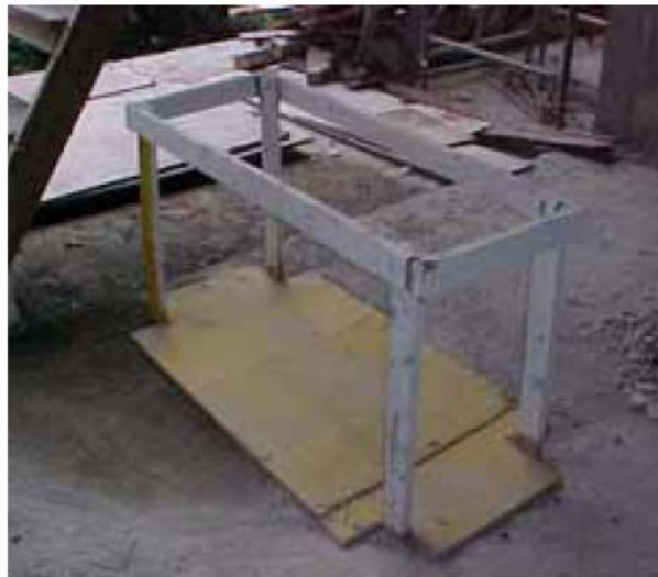
abertura em piso bem protegida
